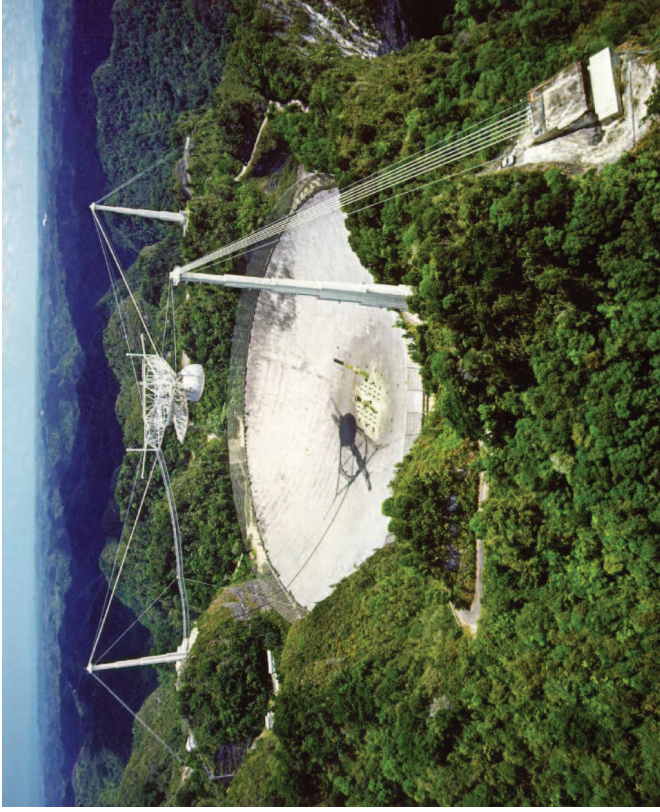
Figuur 45. De radioteleskoop te Arecibo, Puerto Rico, die naast het 'gewone' wetenschappelijke onderzoek gebruikt is om te zoeken naar signalen van buitenaardse beschavingen. Dit gebeurt zonder het reguliere waarnemingsprogramma te verstoren. De teleskoop kijkt min of meer recht omhoog en is gebouwd in een ruwweg sferisch dal van zo'n 300 meter diameter. ( www.nsf.gov/news/immg/media/images/arecibo3.jpg ; the Arecibo Observatory is part of the National Astronomy and Ionosphere Center NAIC, a national research center operated by Cornell University under a cooperative agreement with the National Science Foundation NSF.)
